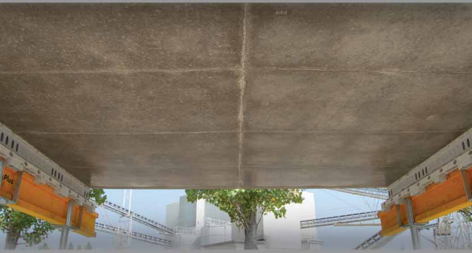
Système de coffrages en plastique pour la réalisation de planchers à décoffrage avancé
