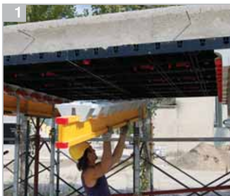
Enlever la poutrelle à H
