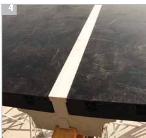
Encastrement des panneaux sur la poutrelle à Y
