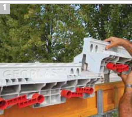
Poser la poutrelle à Y et la cale assemblées
