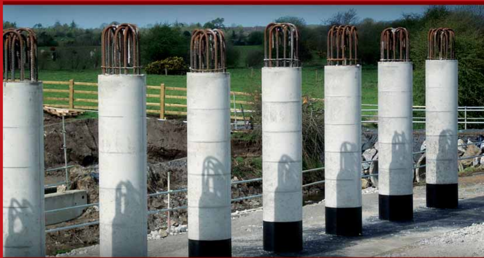
Le 1 ER coffrage pour piliers circulaires
