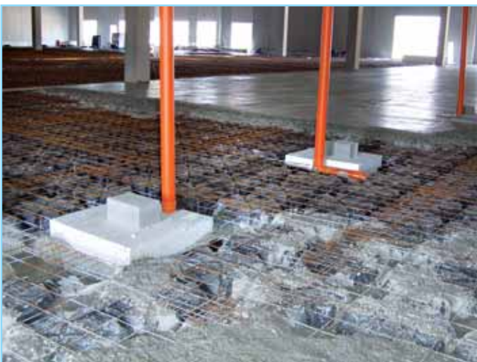
fig. 25) TORINO • Cellule frigorifique 5310 m 2
