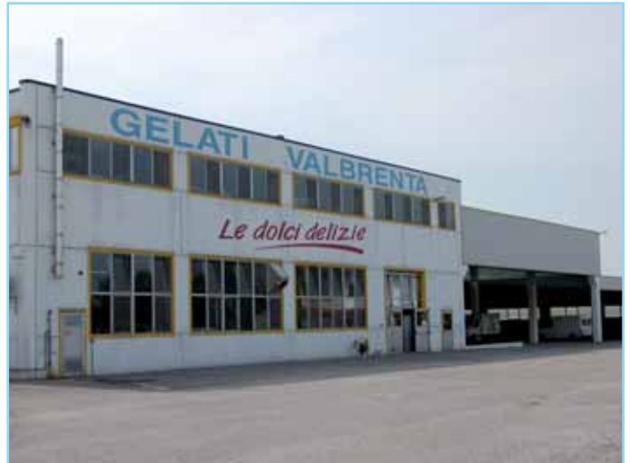
fig. 15) PADOVA • Cellule frigorifique 5320 m 2
