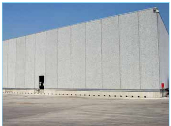
fig. 19) BRESCIA • Dépôt Frigorifique 5815 m 2
