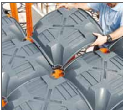
Installation du CAISSON NOUVEAU ELEVATOR®
