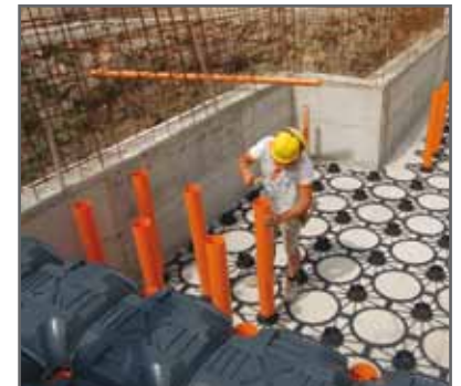
Pose des tubes en PVC
