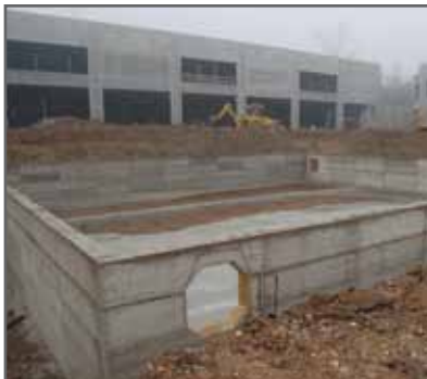
Préparation du radier et des murs, réalisation des reservation.
