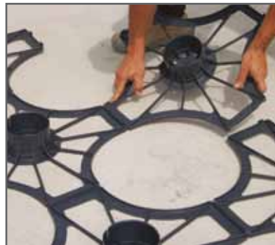
Installation de la grille BASE NOUVEAU ELEVATOR®
